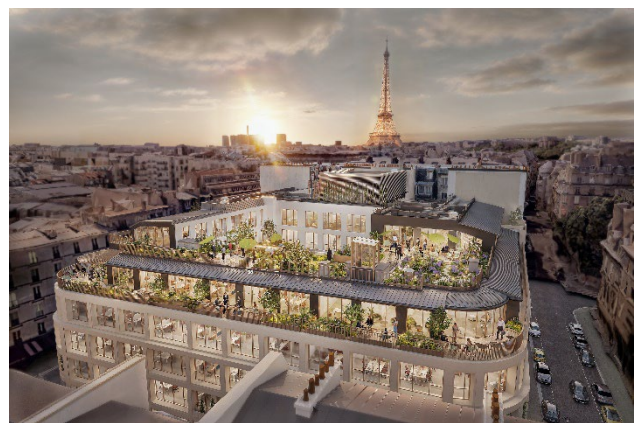
Vue sur le rooftop – ©ORY architecture
