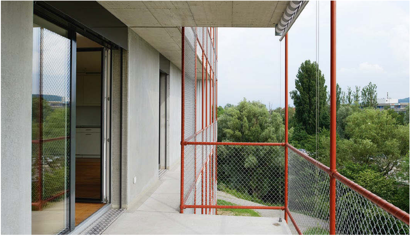
Les appartements de trois et quatre pièces disposent tous de deux balcons. (Photo: Andrea Helbling, Arazebra, Zurich)
