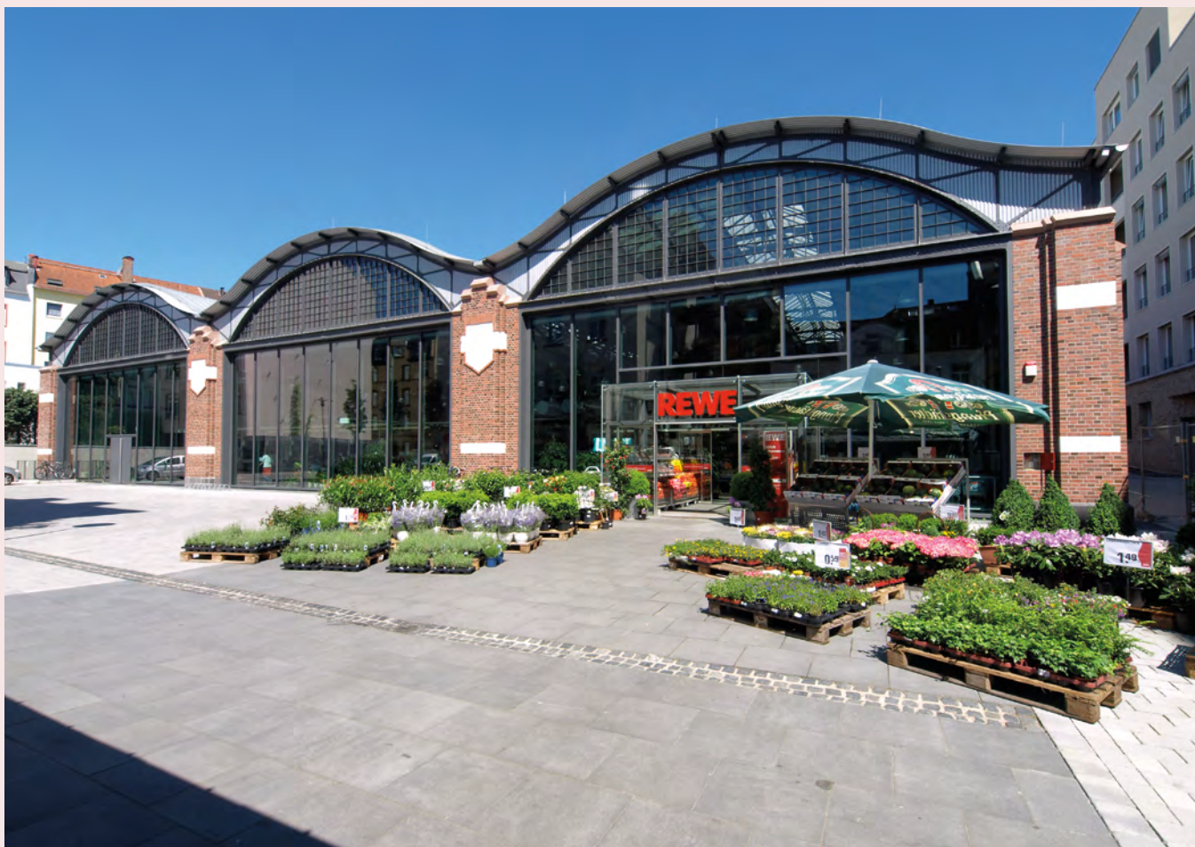
REWE supermarket in Frankfurt Heidestrasse (Source: Lyson Architekten und Ingenieure)
